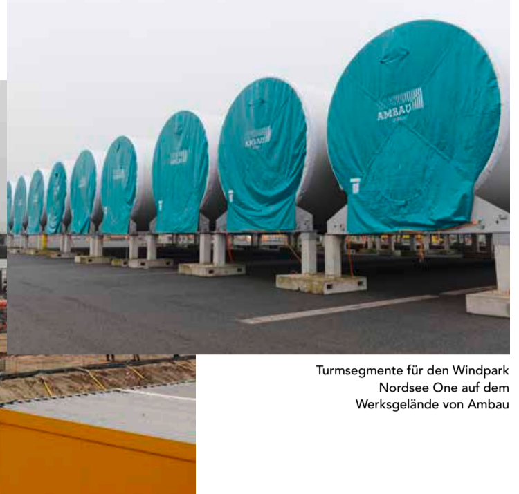
Cuxhavens große Baustelle: Das neue Werk von Siemens nimmt Kontur an
