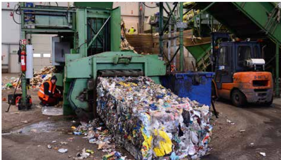
Sortierte Plastikabfälle werden gepresst und an ein Zementwerk geliefert.
