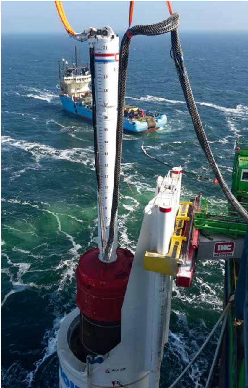
Gekapselt durch Gummi: Der Rammfahl (Monopile) für das Fundament der Offshore-Anlage wird in das Schallschutzrohr eingeführt.
